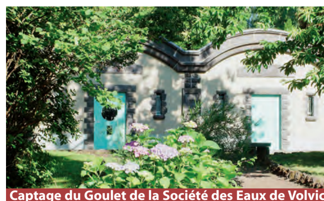
Captage du Goulet de la Société des Eaux de Volvic
