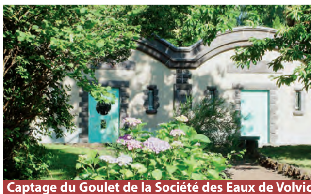
Captage du Goulet de la Société des Eaux de Volvic
